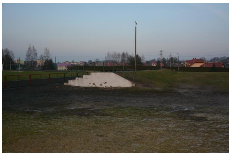
Brak zabezpieczenia przed upadkiem.
