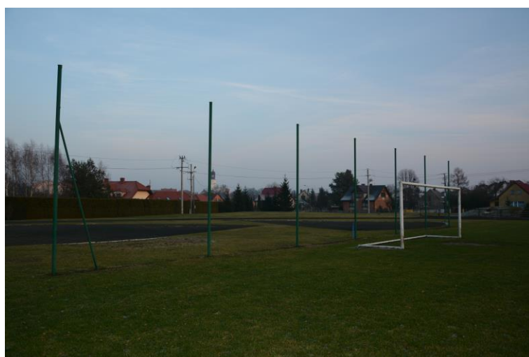
Bramka – brak siatki, ślady korozji biologicznej oraz brak mocowania do podłoża.
