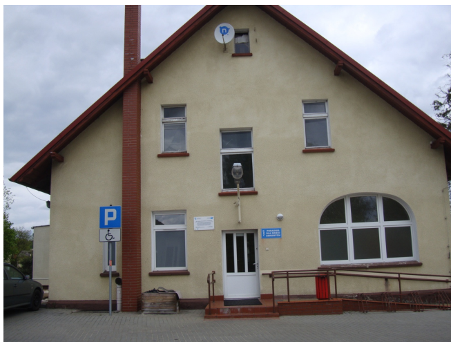
Elewacja boczna – II wejście do budynku
